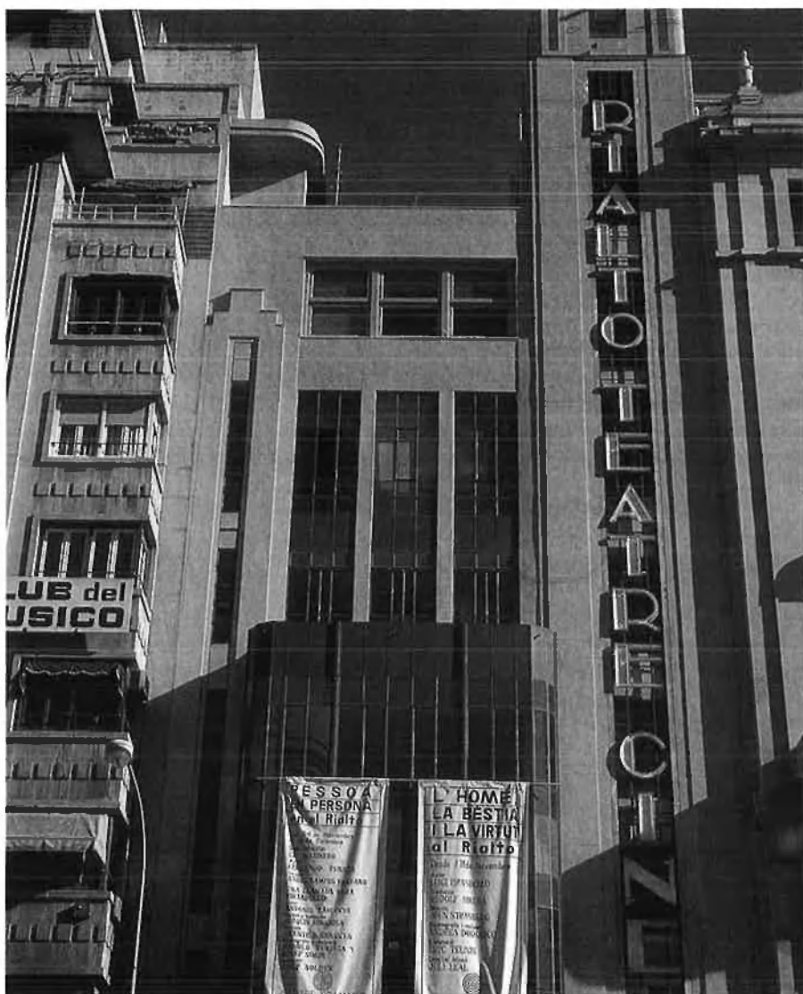
L'edifici de l'antic cinema Rialto, una de les mostres més representatives de l'Art Déco a València.
