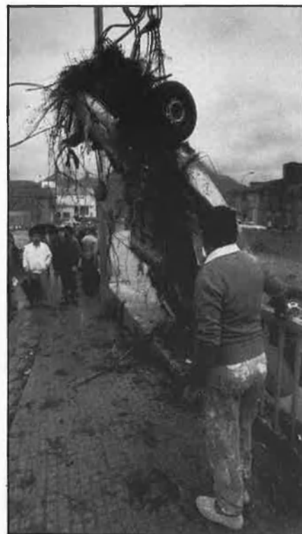
Efectes de les inundacions de 1987 a la Safor.
