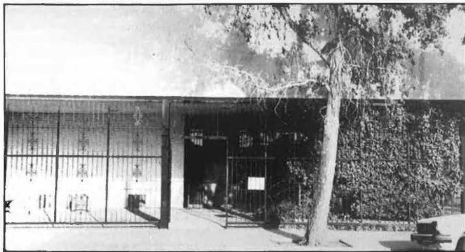
Edifici del CVAT.
