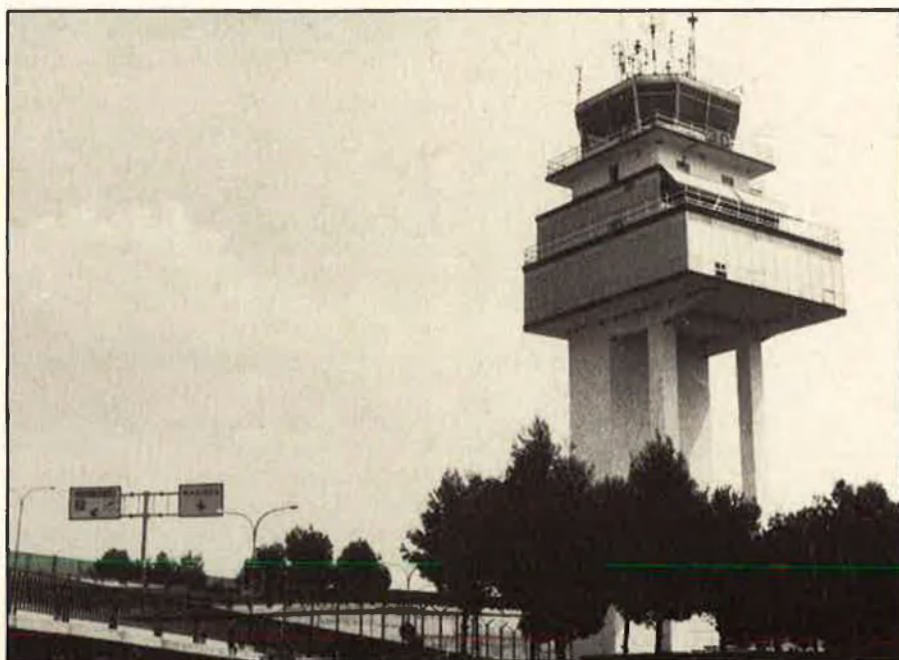
Aeroport de Manises. Grans instal·lacions deficients.
