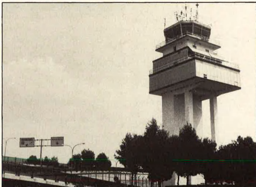
Aeroport de Manises. Grans instal·lacions deficients.
