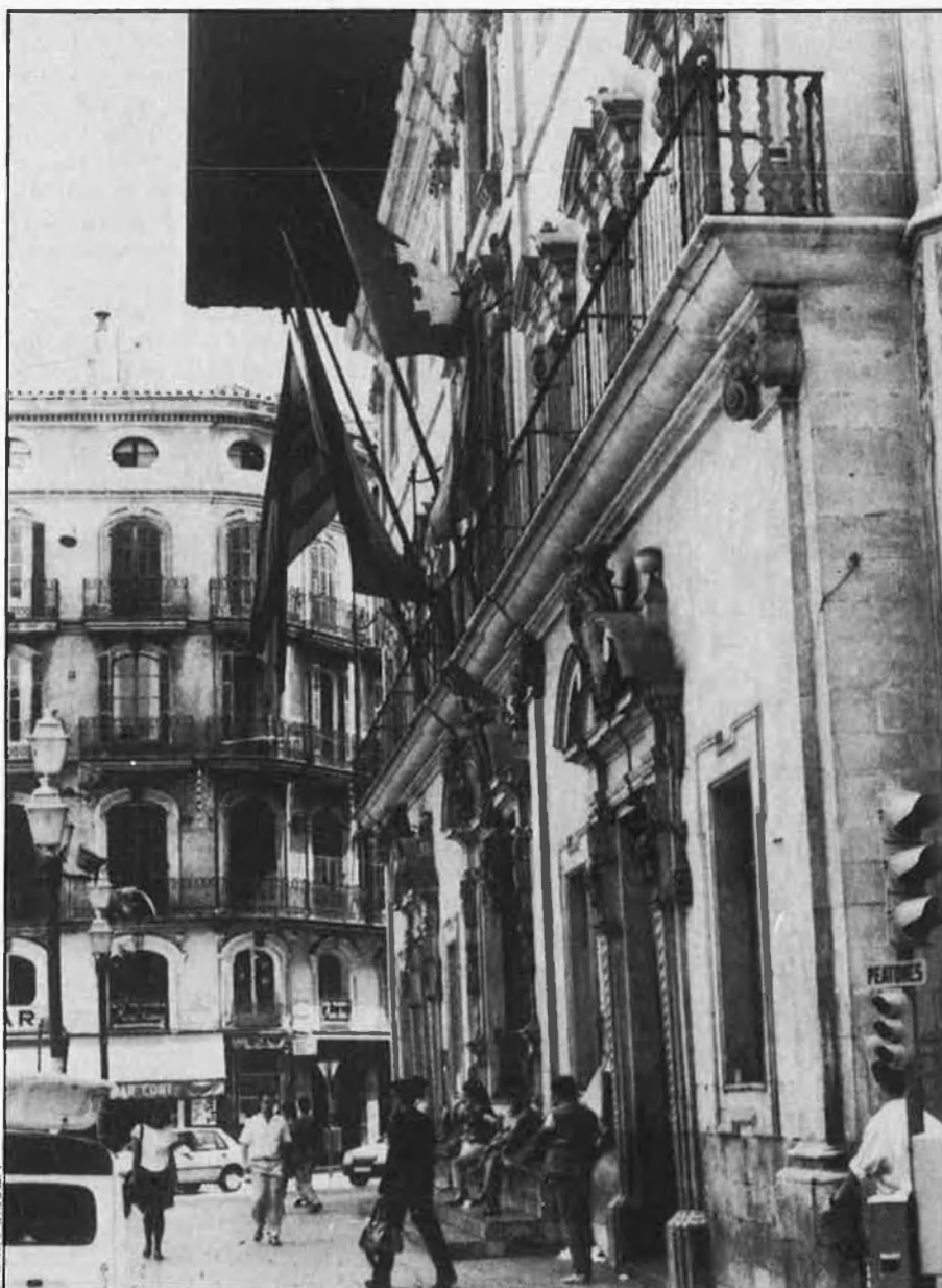
Tot i que són doloroses, l'Ajuntament de Palma està per les demolicions.
