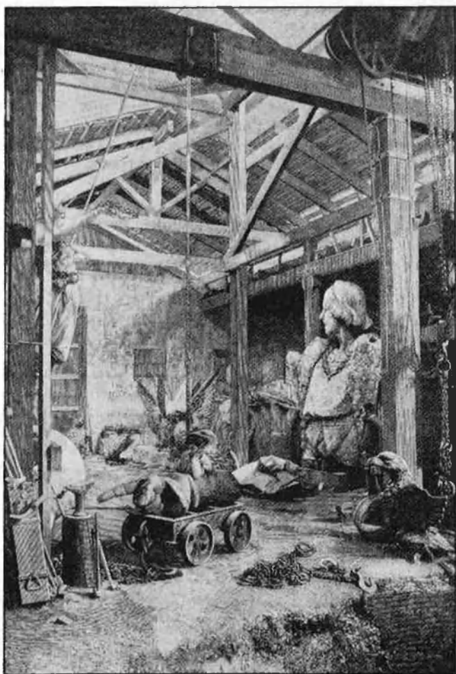
Dalt, el Palau de l'Agricultura. Baix, un monument de la construcció de l'estàtua de Colom.
