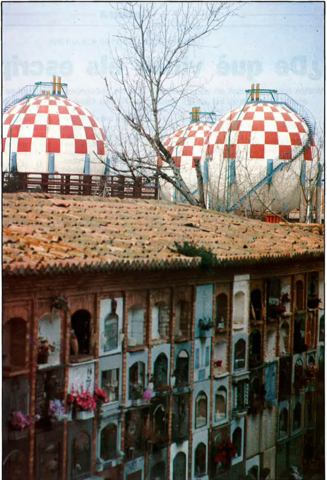
Cementeri de Manises. Per sort, per als habitants d'aquesta casa les instal·lacions de butà ja no són perilloses.
