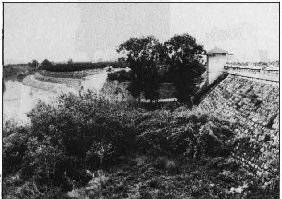
Obres de construcció del nou malecò del Xúquer.
