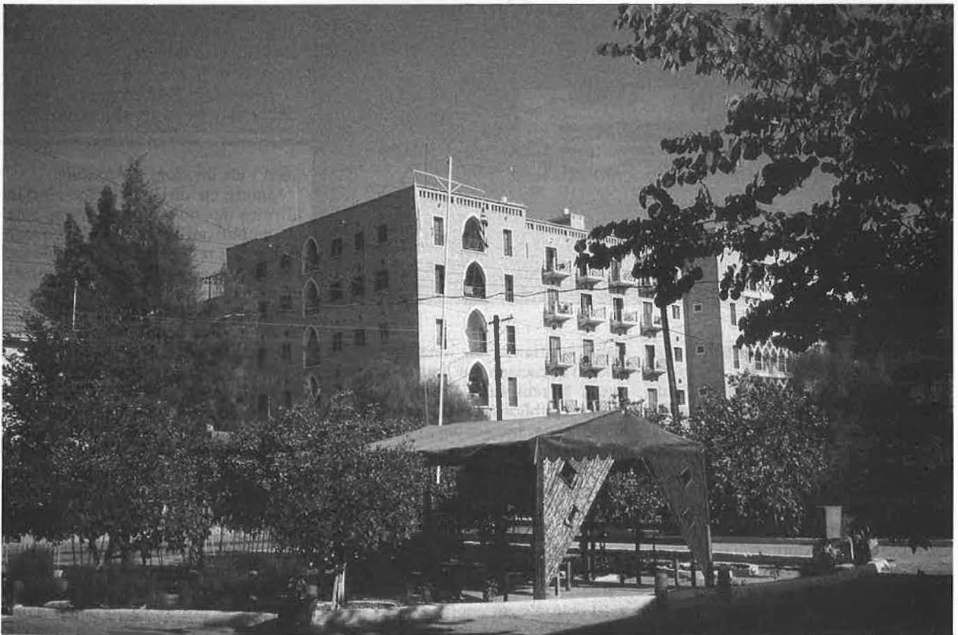
L'hotel Ledra, abandonat al mig de la línia verda.
