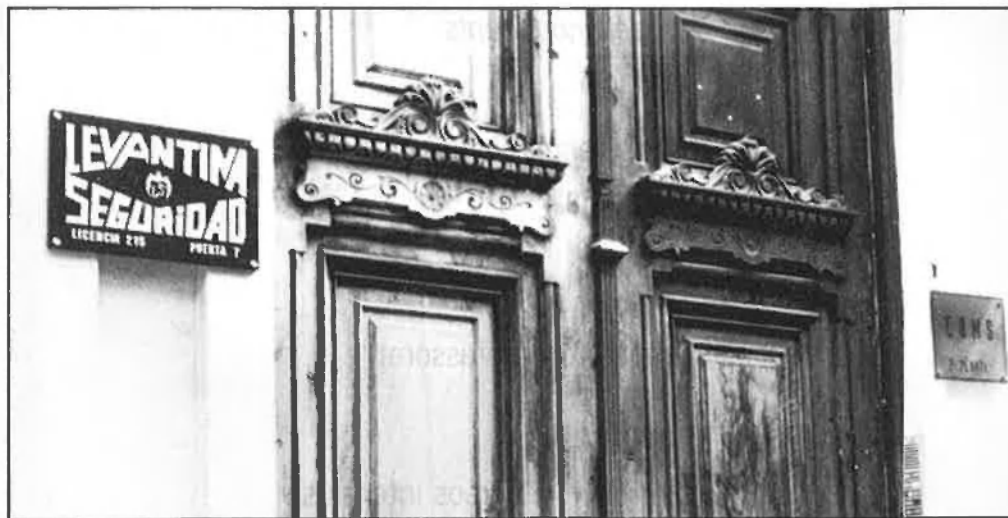
Locals de Cons a València. Compartit oficines i personal, Levantina de Seguridad...
