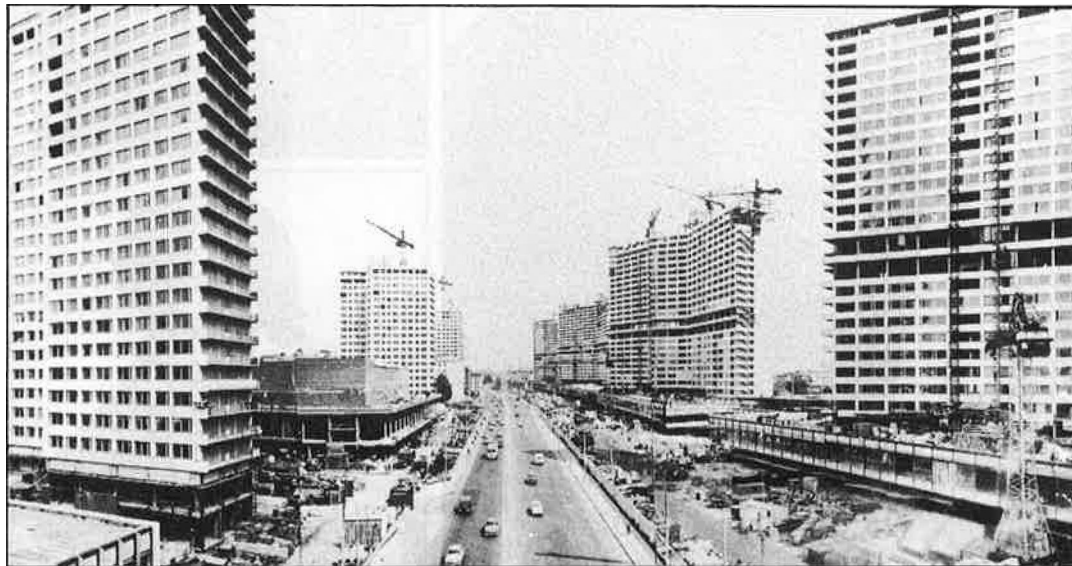
Moscou; el centralisme necessita més i més habitatges.
