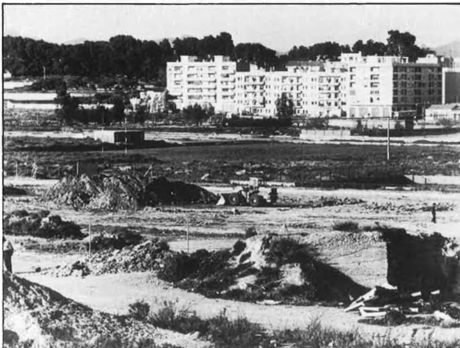
Començament de les obres del Centre de la TVV.
