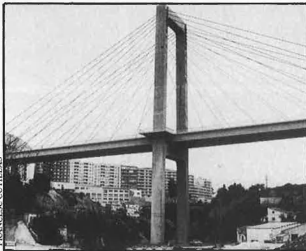
El pont atirantat «Fernando Reig».
