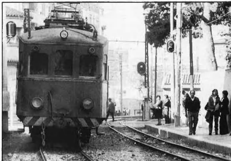
A l'esquerra i a la dreta, instal·lacions i vagons de l'actual trenet. Dalt, línia subterrània a València.
