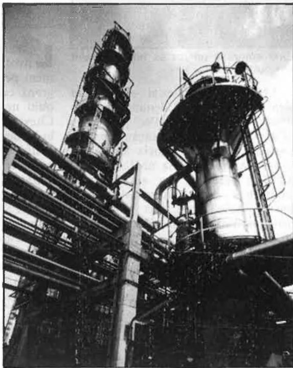
Instal·lacions petrolíferes a Castelló.
