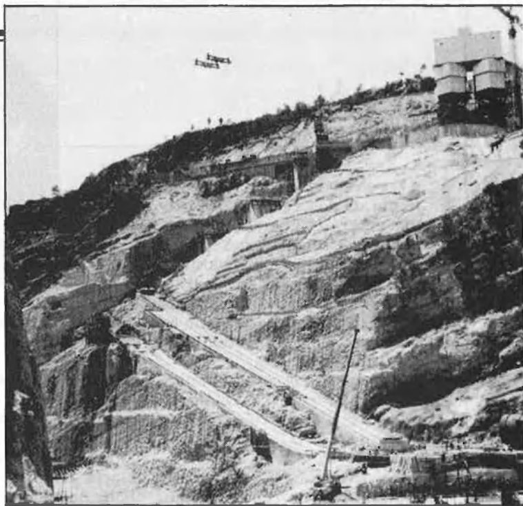
Unes obres ben conflictives
